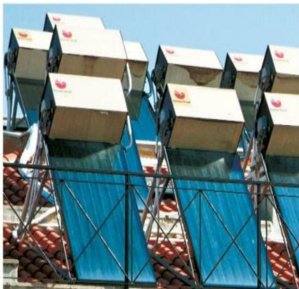
**Pannelli solari in un condominio** Sul tetto sono stati appoggiati molti pannelli termici, uno per ogni appartamento. Ogni pannello ha il suo serbatoio in cima, dove si accumula l'acqua calda: se ne deduce che è un circuito solare aperto (vedi schema a lato) con circolazione naturale, senza pompa.
